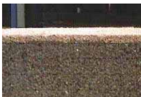
圖 7-24 透水性樹脂混合粒料之構造
