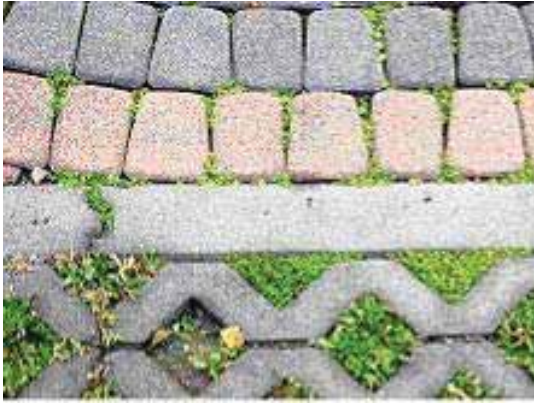
圖 7-15 單元透水磚透水鋪面
